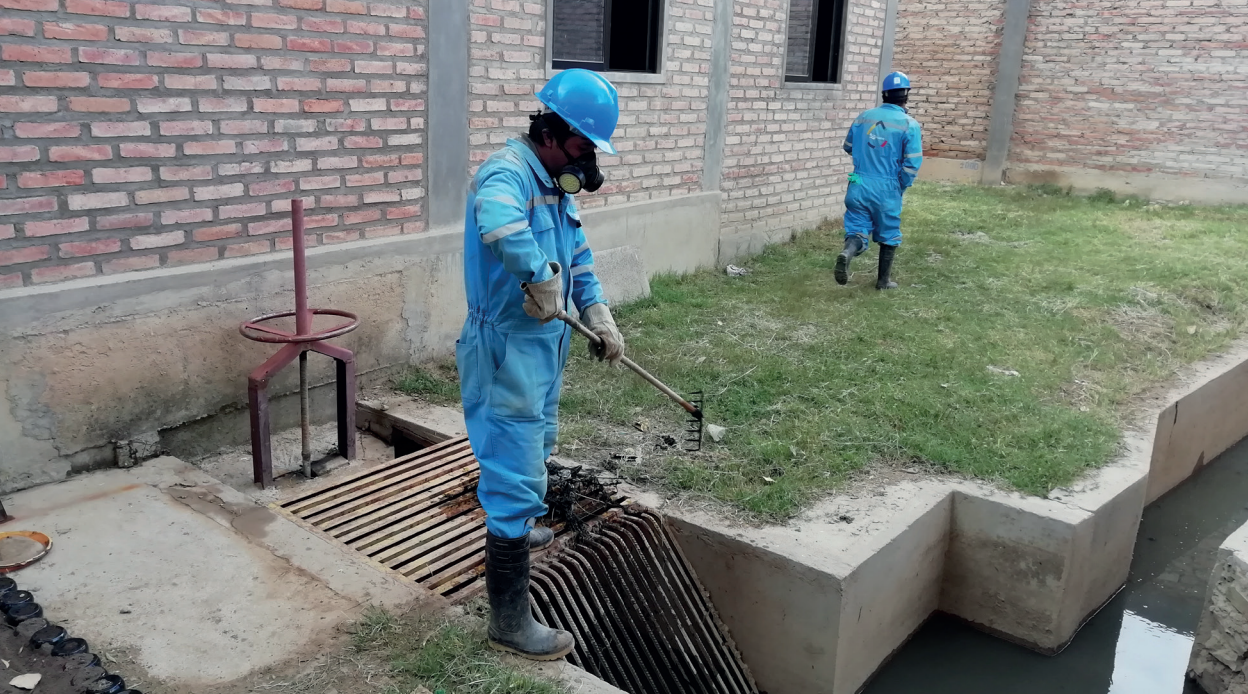
Operador de la Empresa Municipal de Saneamiento Básico de Villazón (EMSABAV) en limpieza de la estación de bombeo.
